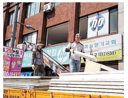
리모델링 공사중인 광주·전남 안보회관
